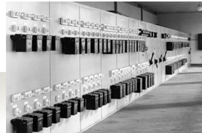
Niederspannungsschaltanlage 1932 auf Zeche Zollverein in Essen.
