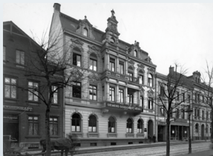
Zentrale der »Siemens-Schuckert-Werke GmbH« in Essen 1903.
