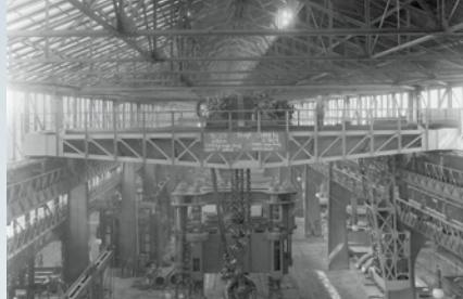
Elektrischer 75-Tonnen Kran bei Krupp in Essen 1895.
