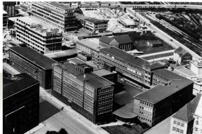
Luftbild der Essener Siemens-Zentrale nach dem dritten und letzten Bauabschnitt 1966.
