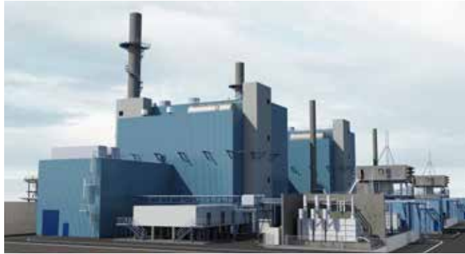
Am 30. August 2019 erhielt Siemens von Evonik den Auftrag zum Bau dieses GuD-Kraftwerkes, das 2022 in Betrieb gehen soll.
